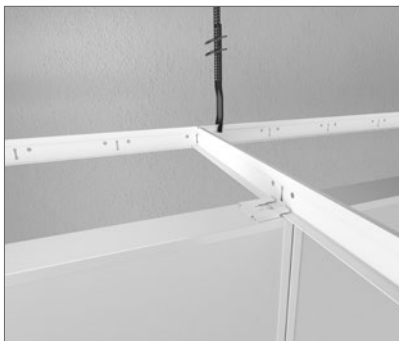
Rockfon Humitec Baffle bevestigd aan Chicago Metallic T24 ECR klasse D plafondprofielen.
